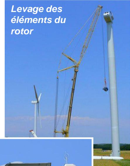
*Levage du rotor complet*
